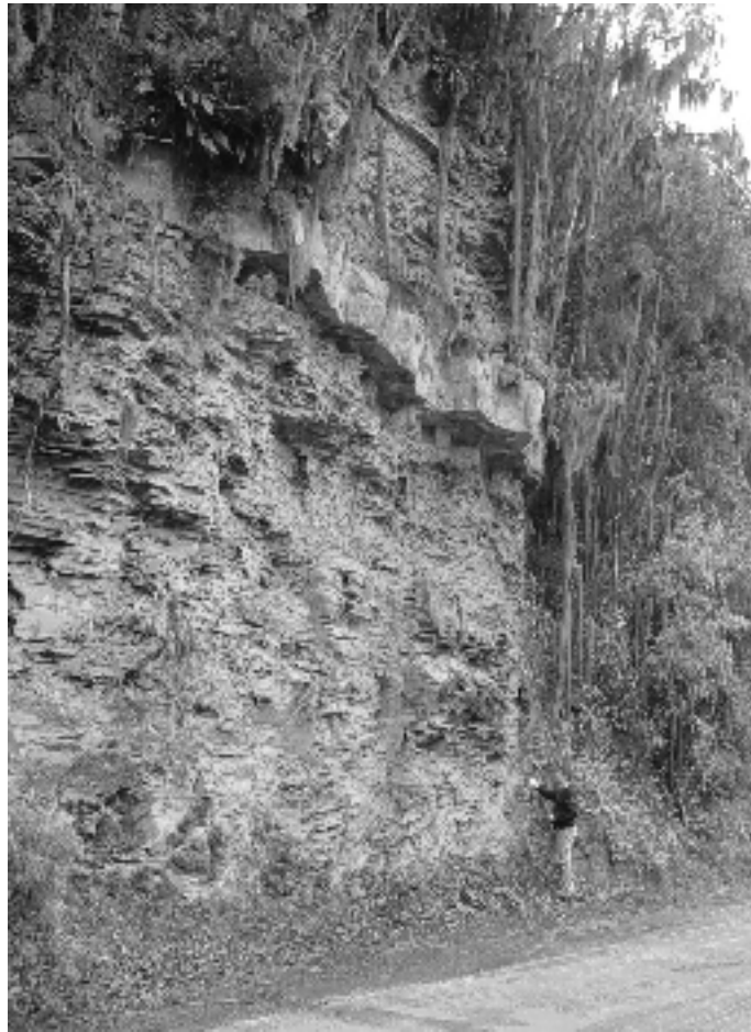
Figura 8 – Processo erosivo na camada de folhelho.
